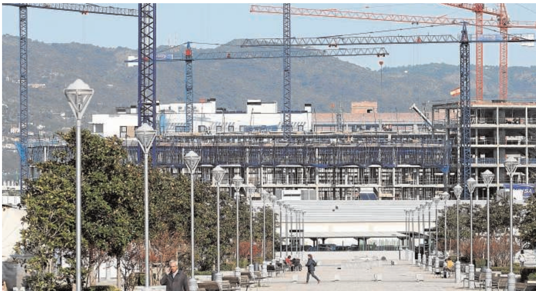
Una promoción de viviendas en proceso de construcción en la zona de Poniente
